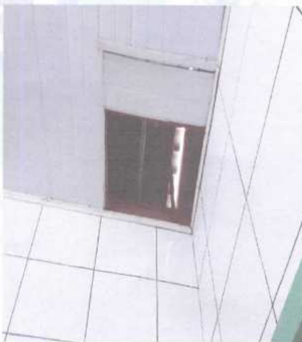
24- Forro com defeito e aberto na cozinha. Espaço deixado entre telhado e cobertura
